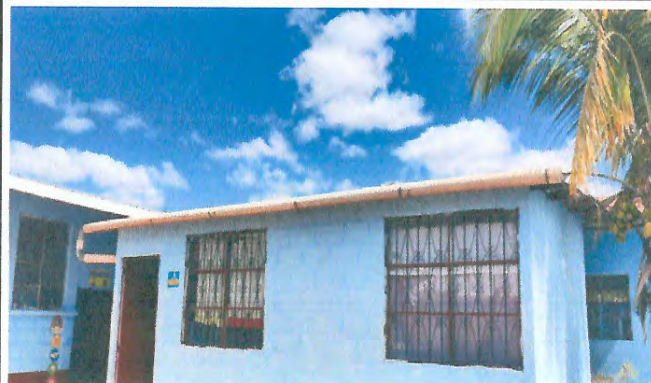
Foto 2: Repación de caída de aguas pluviales
