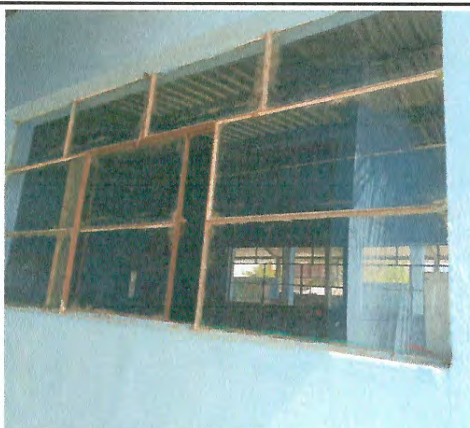
Foto 3: Reparación de ventanas
