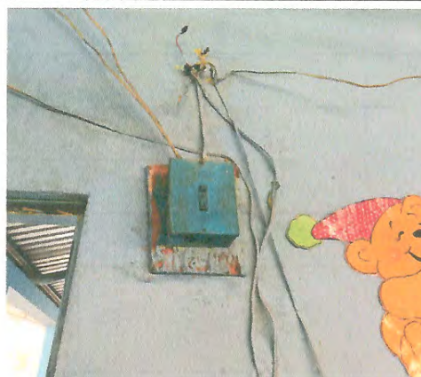
Foto 4: Reparación del sistema electrico
